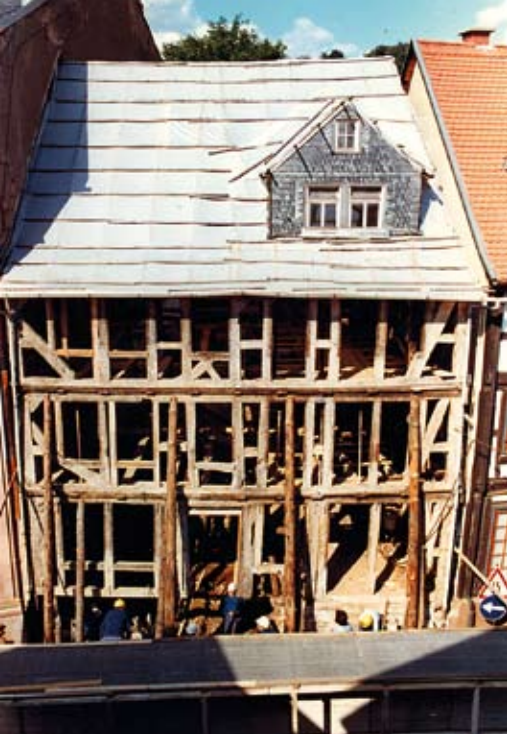
Nach dem Entkernen des Hauses kamen erst alle Schäden zum Vorschein
